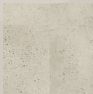
Podlaha v přízemí beton dekor vinyl
