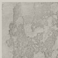
Koupelna stěna a podlaha stěrka
